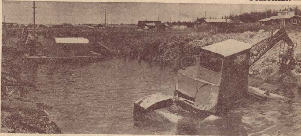
Entreprenørerne har selv konstrueret de søgænde maskiner. Her ses de i arbejde — pælerammeren, der laver den lille havns bolværk, og gravemaskinen. Æen løber bag jordbunkerne til venstre i billedet. Nedenunder viser Kurt Christiansen havneprojektet, som han for øvrigt selv har udført. Han peger på „stoppestedet“, der benyttes, når bådene med pladser på land skal have passagerer om bord eller sætte dem i land efter sejlturen.
